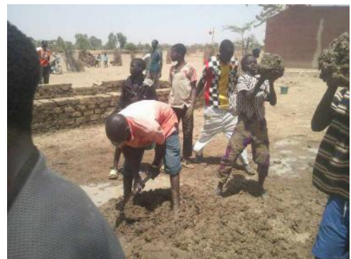
Bouw van de school in Yassalam.
